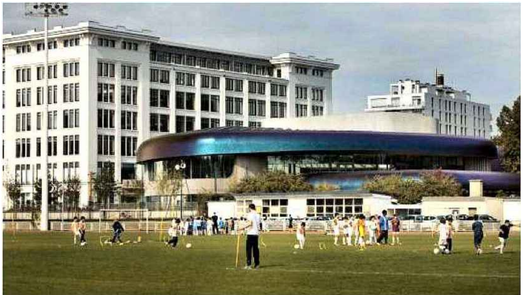
Boulogne-Billancourt. L'ancien siège de Thomson sur le quai Le Gallo a été réhabilité. L'ensemble immobilier proposant 32 000 m 2 de bureaux se compose de l'ancien bâtiment qui date des années 1930 et d'un bâtiment de services d'architecture moderne. Ce dernier héberge restaurant d'entreprise, salles de réunion et auditorium. (DR)
